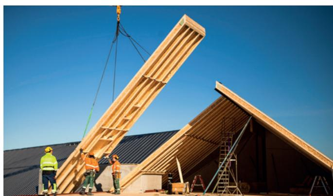
I-BEAM USED IN READY-MADE ELEMENTS
